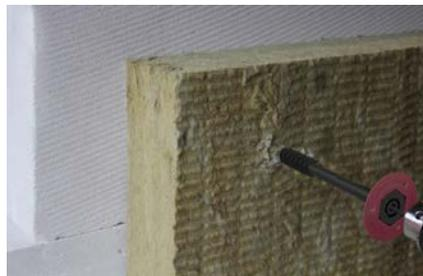
При помощи безударной дрели просверлить отверстие диаметром 12 мм
